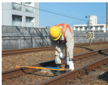
▲水準器でレールの左右方向のねじれやレールの幅を測る。電車が常に安全走行できるように厳しい目で線路の状態を見守る。
